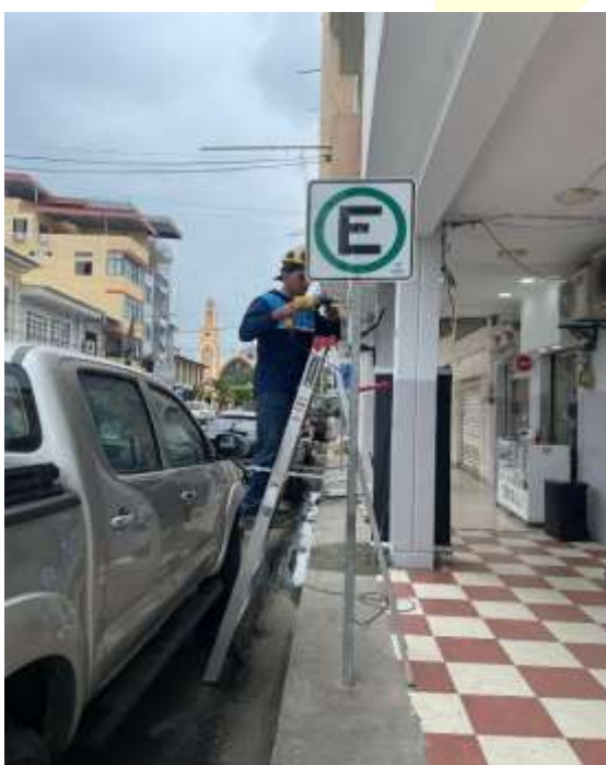
Imagen 5. Colocación de señalización de permitido estacionar
