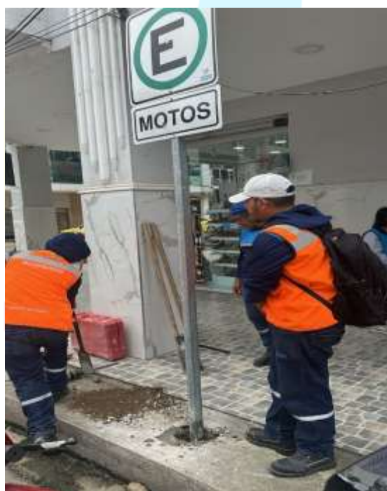
Imagen 6. Colocación de señalización de permitido estacionar motos
