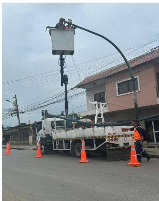
Imagen 4. Colocación de báculo
