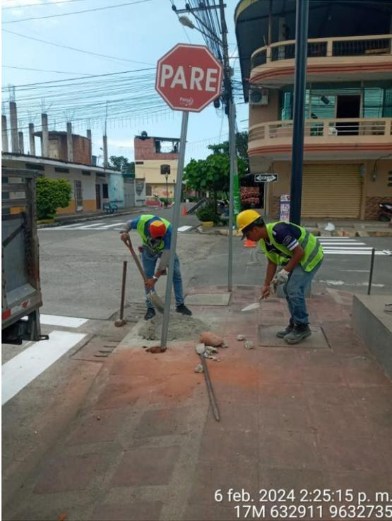
**Imagen 1.** Colocación de señal "PARE"
